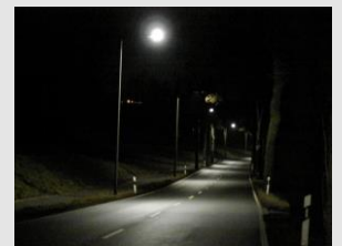
30 Watt LED-Leuchtmittel ersetzen 125 Watt HQL-Leuchtmittel (Bundesstraße im Vogtland)
