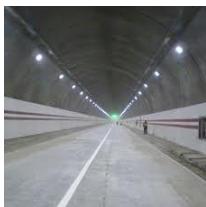
Strassen- u. Versorgungstunnel
