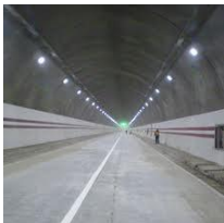
Strassen- u. Versorgungstunnel
