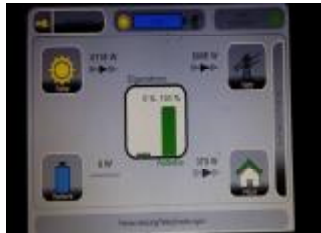
PV Batterie Elektro Solarkraftwerk
