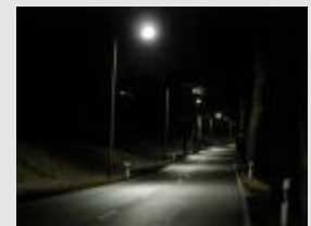
30 Watt LED-Leuchtmittel ersetzen 125 Watt HQL-Leuchtmittel ( Bundesstraße im Vogtland)
