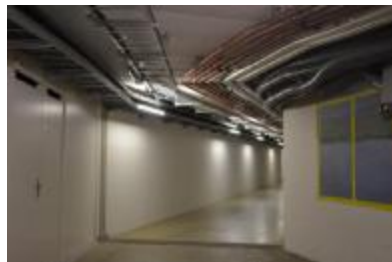
Notbeleuchtungsfunktion, auch bei Stromausfall ist eine Beleuchtung von bis zu 3 Stunden gewährleistet
